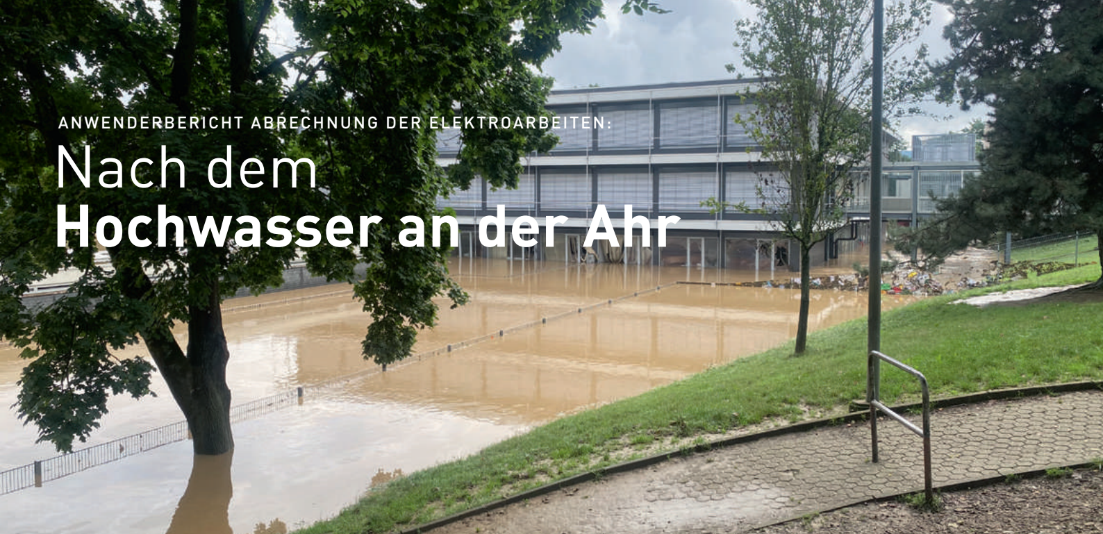
Nach dem Hochwasser im Ahrtal im Juli 2011 die unter Wasser stehende Realschule in Sinzig. (Bild: Elektrotechnik Tietz)
